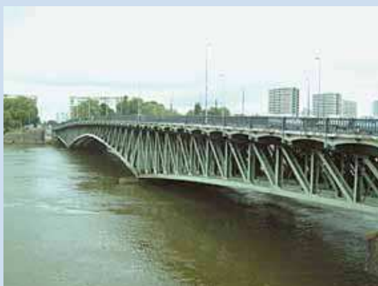
Figure 9 Structure arc avec poutres treillis
