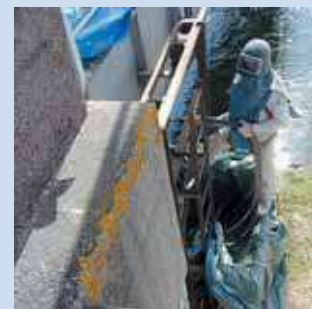
Figure 12 – Essai de décapage
