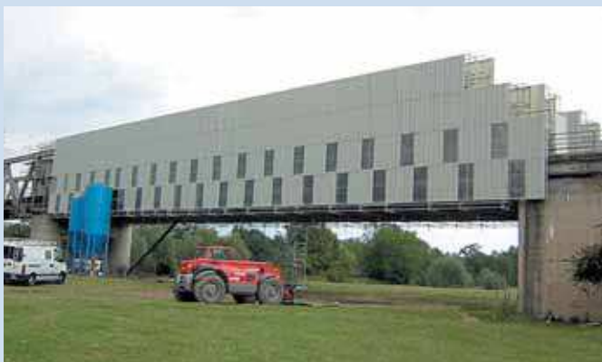
Figure 17 – Exemple d'échafaudage étanche fixe à plancher jointif permettant une bonne récupération des résidus de décapage
