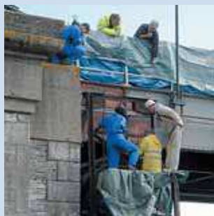
Figure 10 – Choix de la zone à décaper
