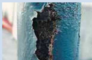
Figure 3.4 – Enrouillement sous-jacent
