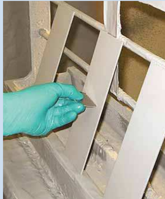
Figure 18 – Contrôle de l'épaisseur humide à la jauge type peigne
