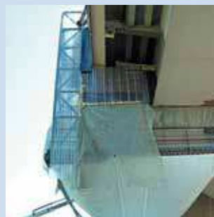
Figure 11 – Protection de l'ouvrage
