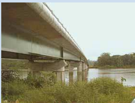
Figure 8 Structure mixte bi-poutre
